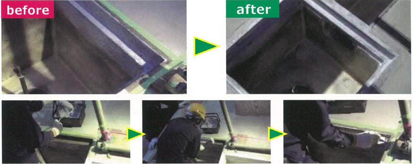
■ ポリウレア液剤をペイントローラーで補修部分に塗布し、刷毛、ヘラで細部・角・隅等を修正すれば作業完了。
